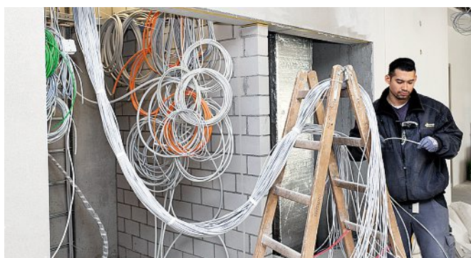
Bis zum Schulstart gibt es im neuen Haus noch viel zu tun.
