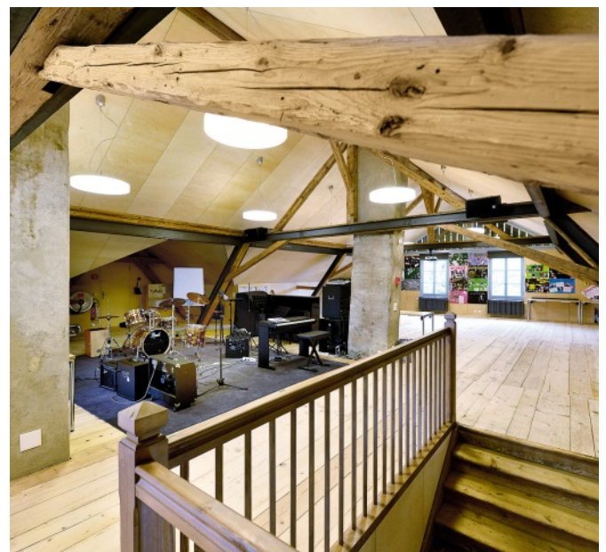
Der alte Dachstuhl wurde wiederbelebt und vielseitig nutzbar gemacht.
