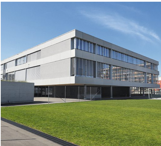
Nicht alles im neuen Schulhaus konnte auf das Modell Tagesschule angepasst werden, da das Baukonzept schon vor Projektstart feststand.
