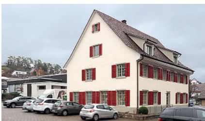
Die Alte Kanzlei wird neu die Tagesstrukturen beherbergen.
