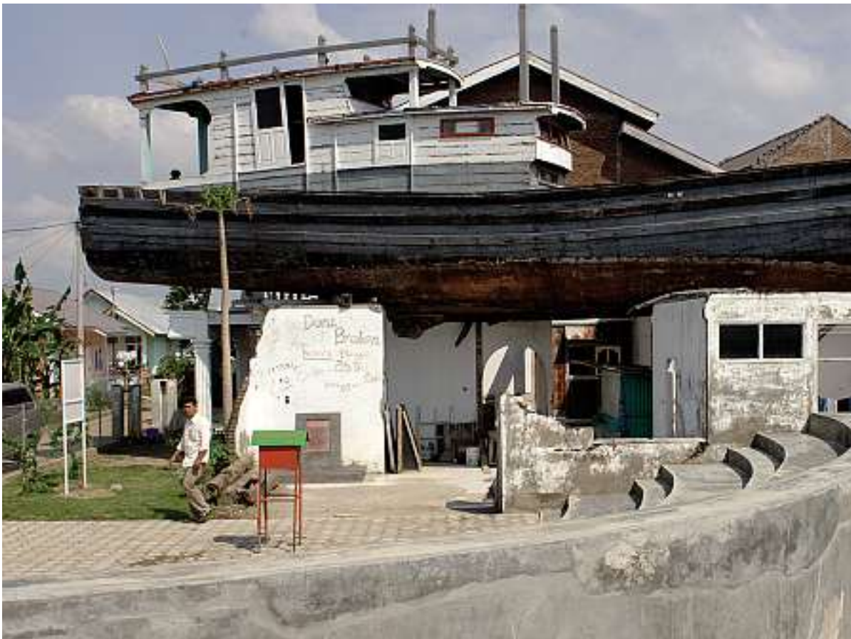
In Lampulo, einem Vorort von Banda Aceh, sitzt ein vierzig Meter langes Fischerboot auf den zerstörten Dächern von Wohnhäusern. An Bord waren damals 59 Fischer – alle überlebten.
