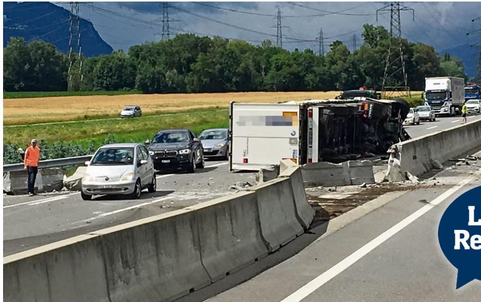
Auf der A9 durchbrach ein Lastwagen, der in Richtung Martigny unterwegs war, das Betonelement.
