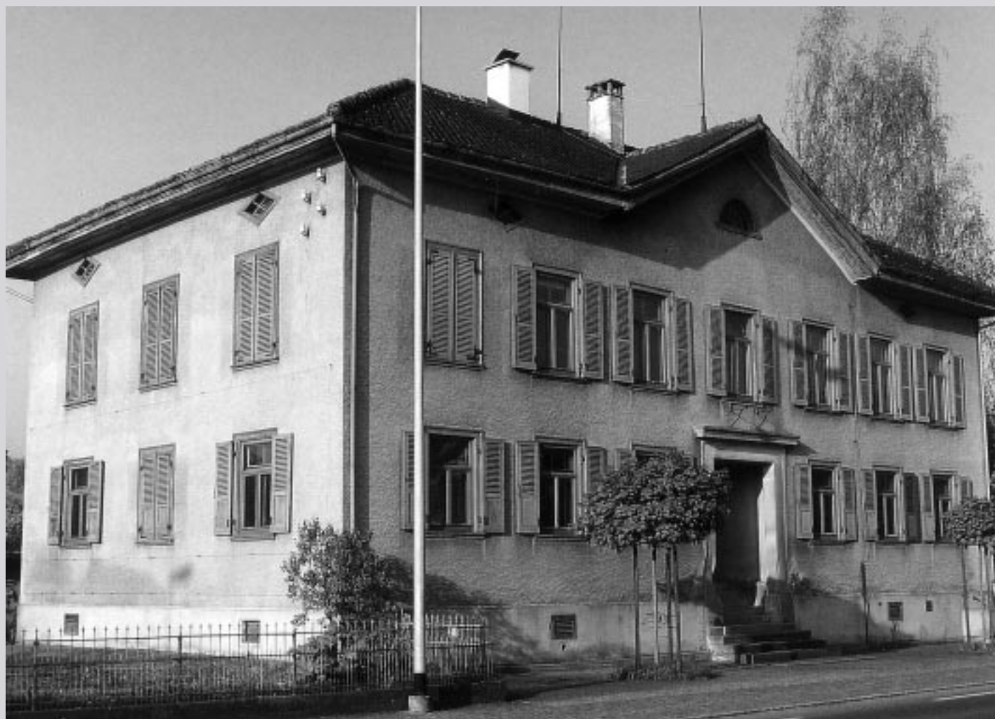
Hort des Schulmuseums und gleichzeitig sein zentrales Objekt: Das Pisé-Schulhaus aus ungebranntem Lehm aus dem Jahre 1847. Im Bild: Das Schulhaus Mühlebach vor der Renovation.
