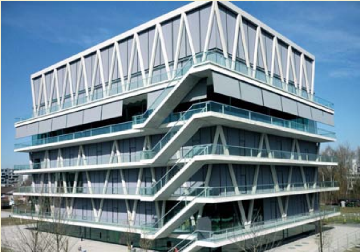
Architektonische Antwort auf pädagogische Forderungen: Schulhaus Leutschenbach.
