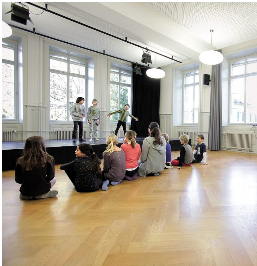
Grosszügige Vorväter spielen heutiger Pädagogik in die Hände: Ein Schulzimmer wurde zum Theater- und Versammlungsraum umgebaut. Bei der Sanierung wurden Eichenparkettböden vom Linoleum befreit sowie Stuckaturen und Wandmalereien freigelegt.
